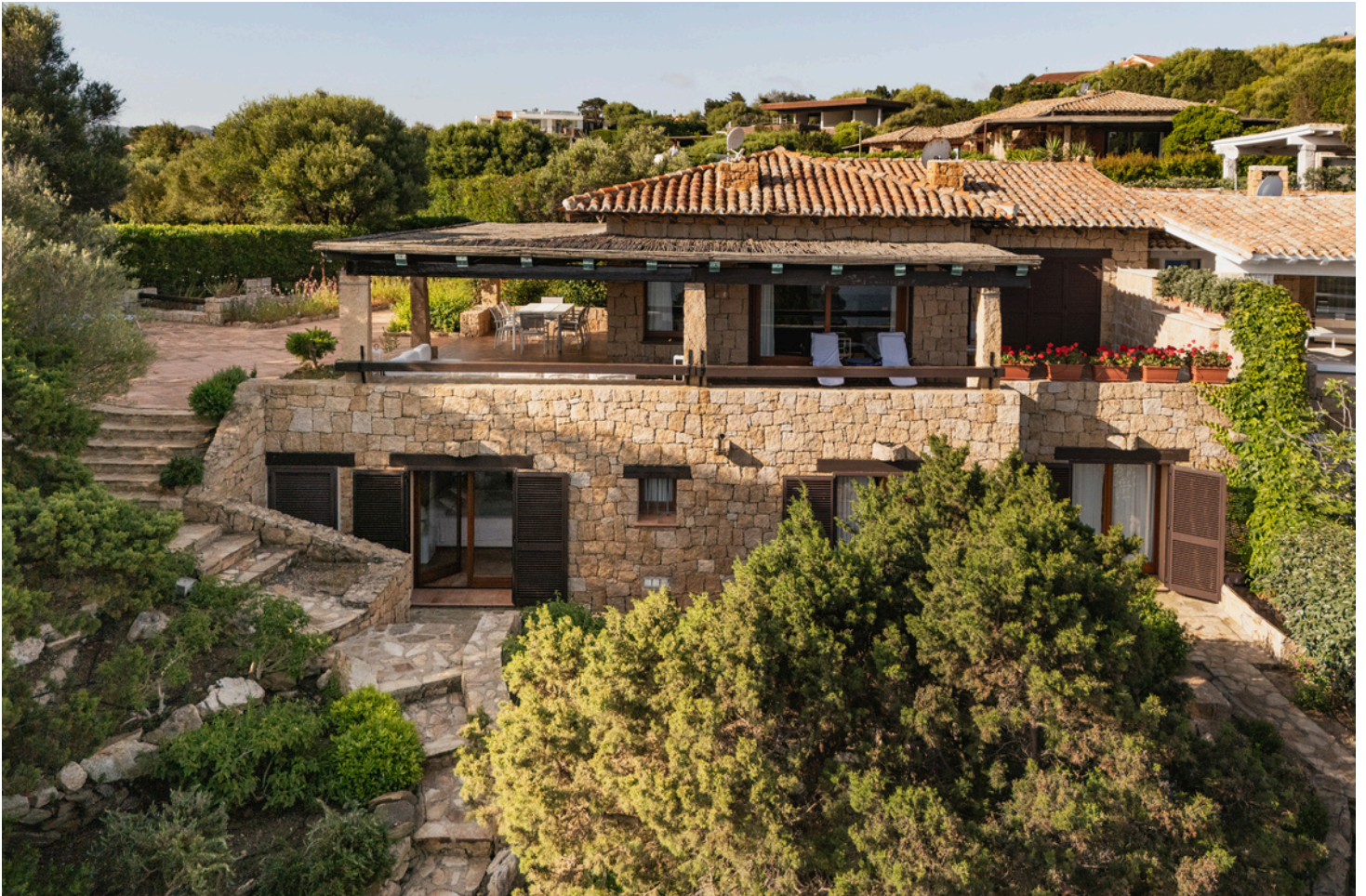
Una prospettiva frontale della proprietà
